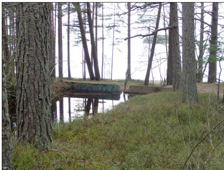
23 Sillan pohjoispuolella ojan päässä on betoninen patorakennelma.
