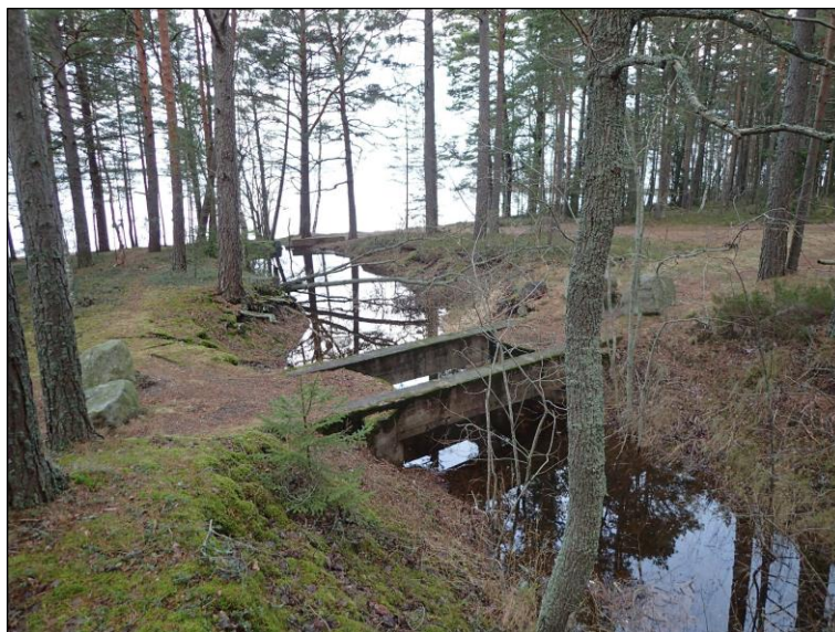
20 betoninen siltarakenne, pohjoiseen.
